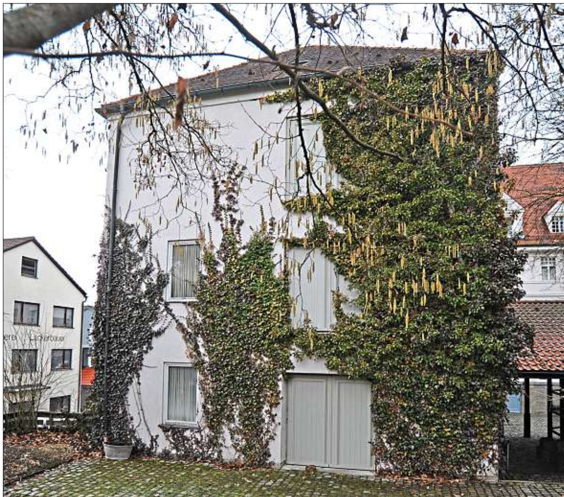
Eines ist ziemlich klar , der Anbau an der Pflleggasse, den das damalige Landratsamt bekommen hat, der wird auf jeden Fall abgerissen. Sonst sind aber noch viele Fragen offen. – Foto: Lukaschik
